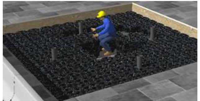
*Installer les tuyaux d'aération ou d'irrigation au sein du squelette RootStock*
