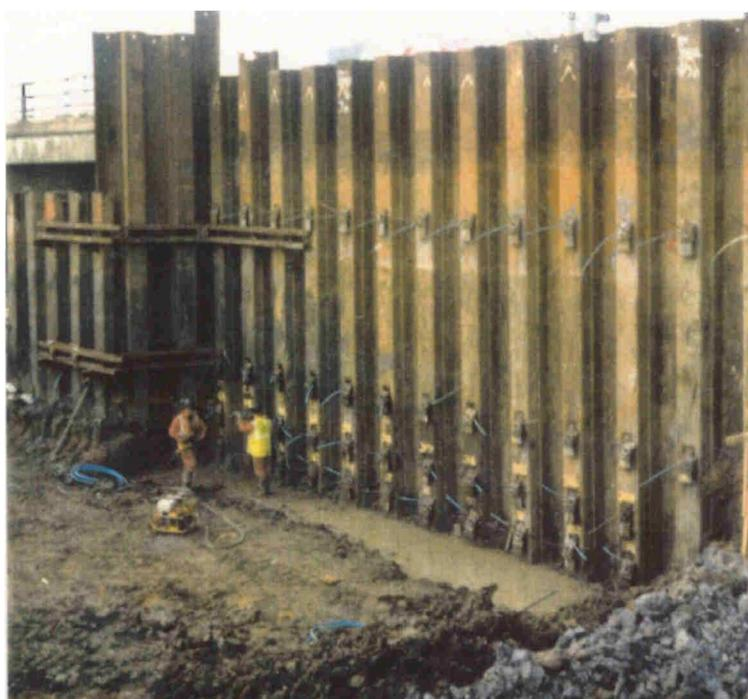
Il fut installé 4 rangées d'ancres Manta Ray MR1 sur 9 mètres de hauteur de palplanches. Les ancrages furent enfoncés au moyen d'un brise roche JCB.
