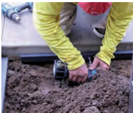
Installation d'une lambourde
